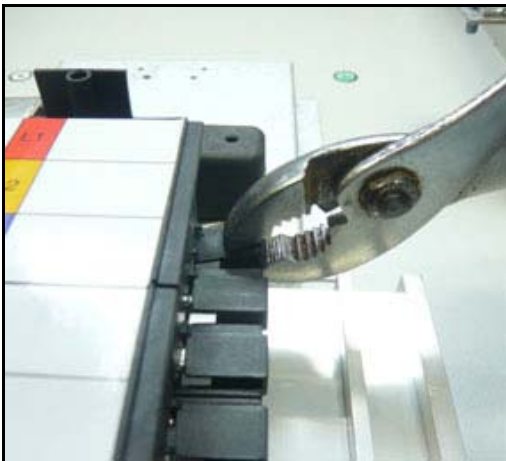
รูปที่ 1 การหักพลาสติกครอบบัสบาร์ก้างปลา
